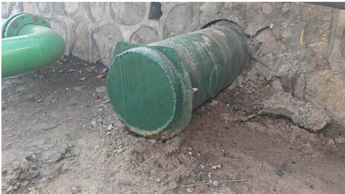
图 7.1-1 矿井水溢流排放口封堵
