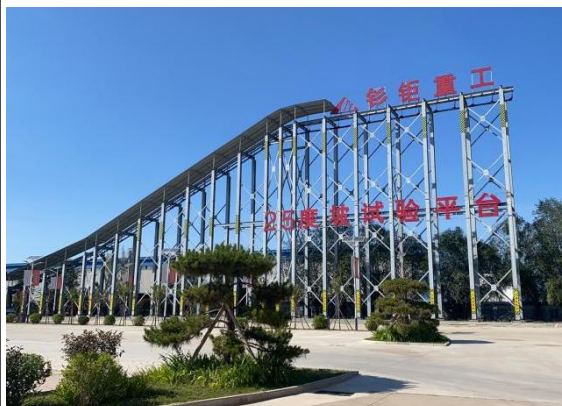
25 度坡试验平台
