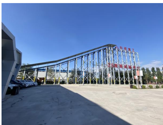
25 度坡试验平台
